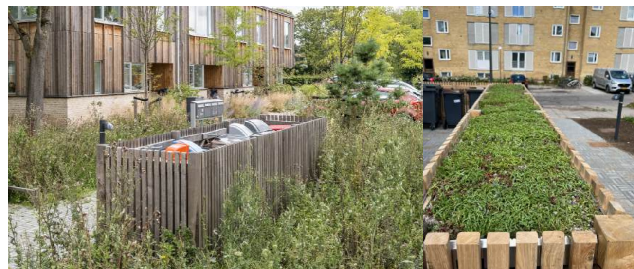
Eksempel på høj kvalitet af renovationsenhed omgivet af beplantning og sedumoverdækning (Tingbjerg, SLA)
