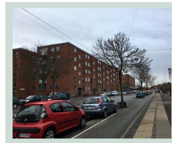
Velfungerende, almene boliger ved Finsensvej.
